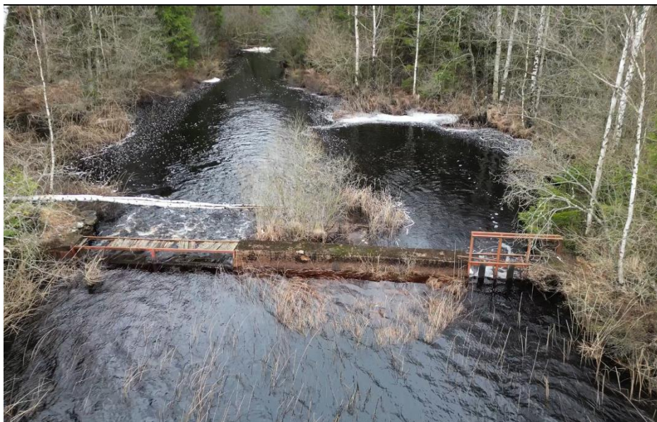
Figur 3. Dambyggnad med utskov och skibordsöverfall.
